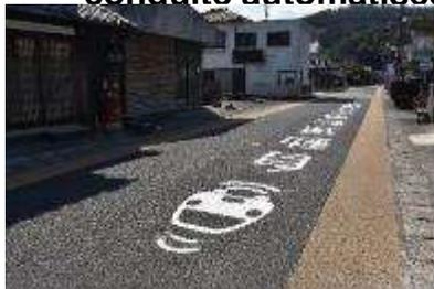
Une conception uniforme du marquage routier pour une trajectoire de conduite de véhicule automatisé
