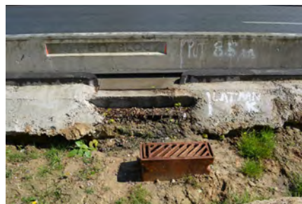
Obra de excavación para un valle. La ranura debajo del borde deja pasar el agua de la carretera, mientras que el conducto servirá de desagüe.
