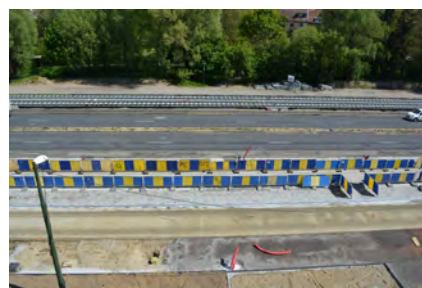
Vista general de una fase de ejecución, desde el tercer piso del edificio de la CRR en Woluwe
