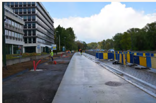
Remodelación en el lado de los edificios.
